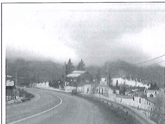
Vedere spre proprietate- care înconjoară cabana salvamont(1)
